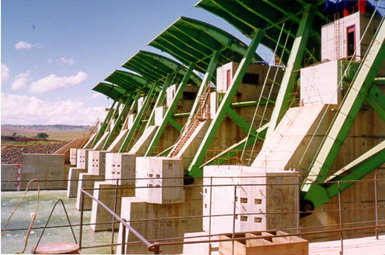
Las compuertas radiales se utilizan normalmente para controlar el nivel de agua dentro de una presa o de un canal de abastecimiento de agua. Las compuertas radiales suministradas por **hydrostec** son diseñadas especialmente para una larga vida de trabajo con condiciones operacionales difíciles.
